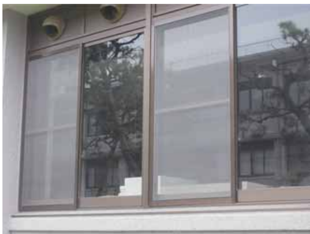
写真1：網戸を取り付けている窓(夏場は窓を開けることができます)
