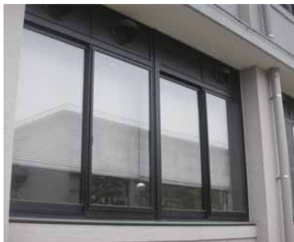
写真2：網戸を取り付けていない窓
